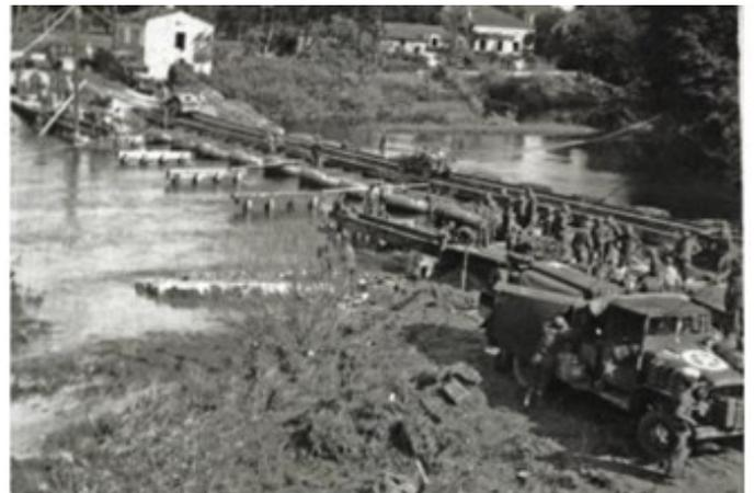
***Les Allemands ont fait sauter le pont sur la Moselle à l'entrée de Bayon. En attendant de pouvoir le réparer, les Américains ont jeté un pont de bateaux sur la rivière pour permettre le passage des véhicules.***
